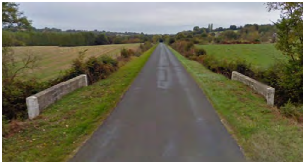
Exemple de pont avec parapet
