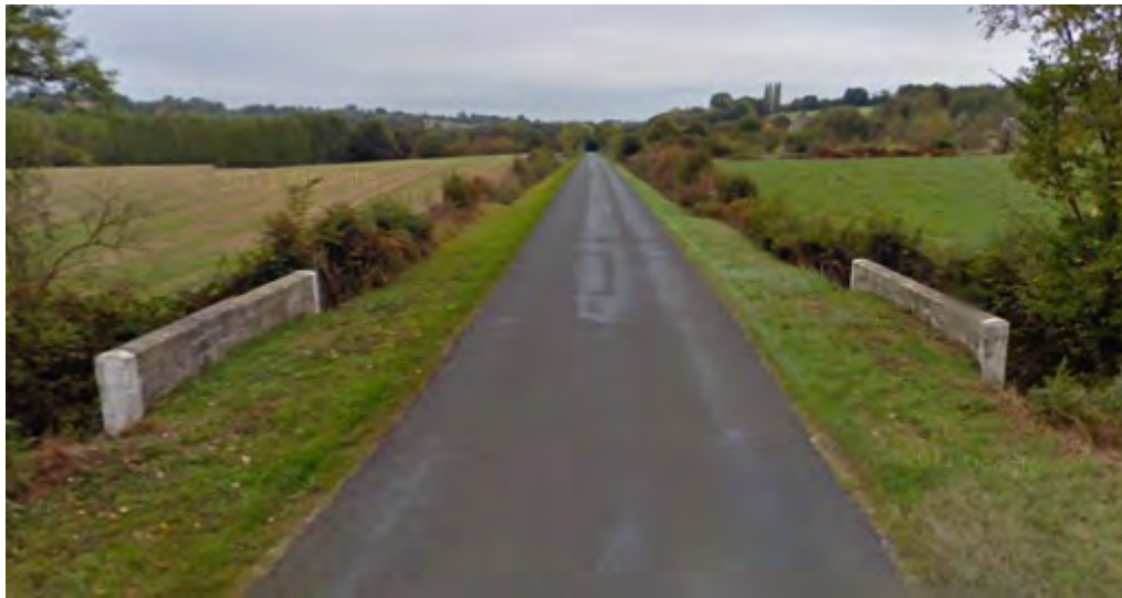
Exemple de pont avec parapet
