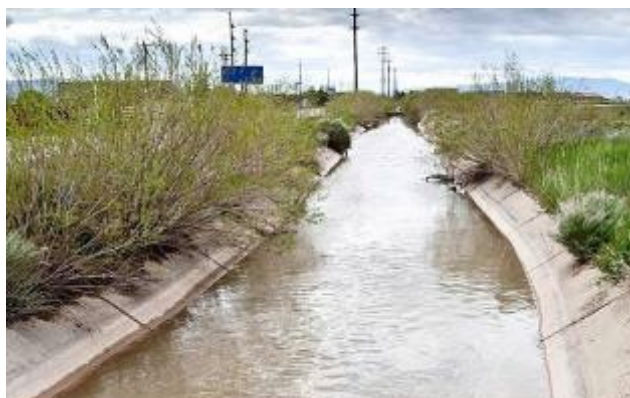
Un fossé maçonné sur le terrain
